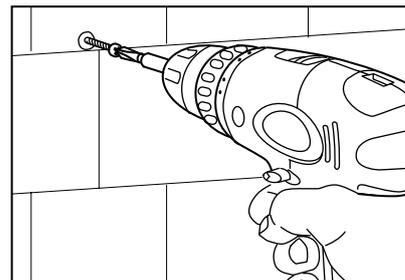
Avant de serrer les vis, n'oublie pas de remplir les trous avec du silicone sanitaire. Lorsque tu serres les vis, veille à ne pas encore les visser à fond.
