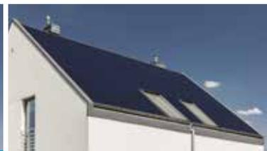
L'installation solaire SOLSTRÅLE intégrée est une installation solaire adaptée aux toits inclinés. À la fois haut-de gamme et esthétique, le système intégré Solrif® de la société Ernst Schweizer AG est étanche et se substitue au revêtement de la toiture.
