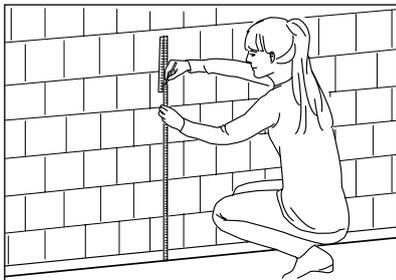
Wenn du die Höhe deines Waschbeckens festgelegt hast, misst du vom Boden bis zur Oberkante des Waschbeckenschrankes und ziehst eine Linie (1). Dann misst du ab, wo die Befestigungslöcher gemäss Montageanleitung hinkommen, und markierst dies ebenfalls mit einer Linie (2).
