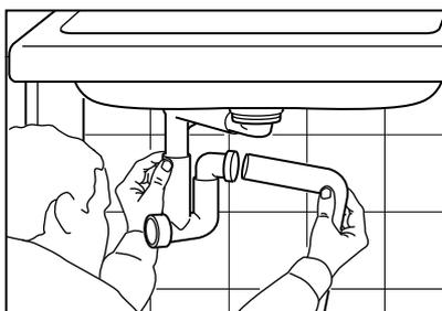
Sobald das Silikon trocken ist, schliesst du die Siphoninstallation ab und verbindest alle Schläuche der Mischbatterie mit dem Wasseranschluss, wie in der Montageanleitung beschrieben.
